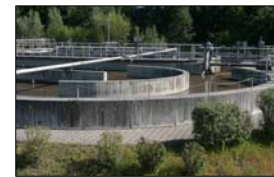
Kläranlage Weilheim, Foto: LfU
